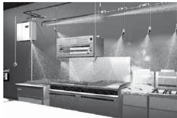
Abb. 1 Beispiel einer Kleinlöschanlage über einer Frittiereinrichtung
