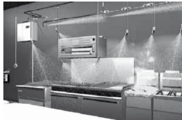
Abb. 1 Beispiel einer Kleinlöschanlage über einer Frittiereinrichtung
