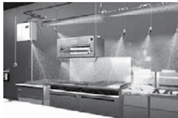
Abb. 1 Beispiel einer Kleinlöschanlage über einer Frittiereinrichtung
