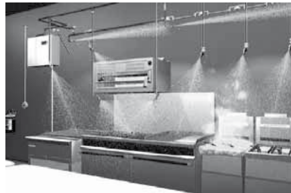
Abb. 1 Beispiel einer Kleinlöschanlage über einer Frittiereinrichtung
