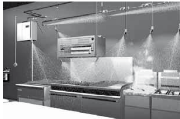
Abb. 1 Beispiel einer Kleinlöschanlage über einer Frittiereinrichtung
