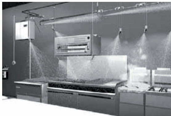
Abb. 1 Beispiel einer Kleinlöschanlage über einer Frittierereinrichtung
