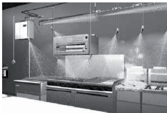
Abb. 1 Beispiel einer Kleinlöschanlage über einer Frittiereinrichtung
